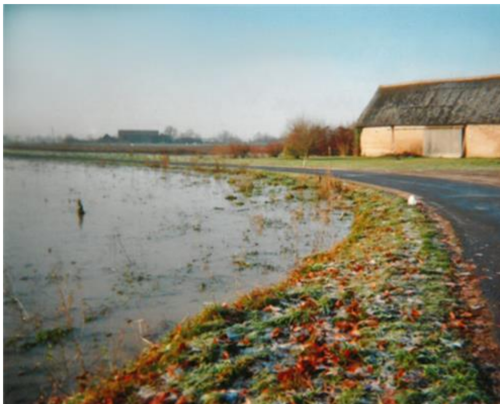
Inondations Route de Vienne en Val Fin mai/début juin 2016
